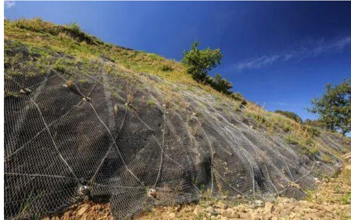
Şekil 2.3. Su değişiminden kaynaklı heyelana karşı geonet kullanımı
