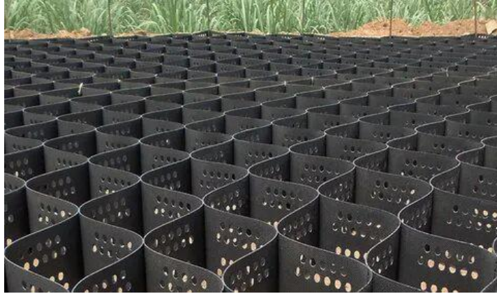
Şekil 2.7. İçerisi zemin, kaya ya da betonla doldurulmuş üç boyutlu petek tarzı elaman olan geocell (geohücre) örneği
