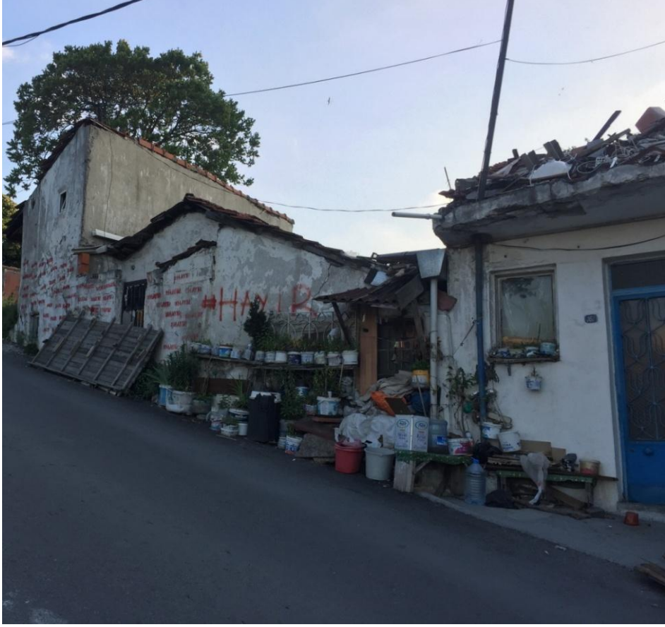
Foto 9: Sarıgöl Mahallesinde çevresindeki evler yıkıldıktan sonra kalan ve halen kullanılan bir gecekondu
