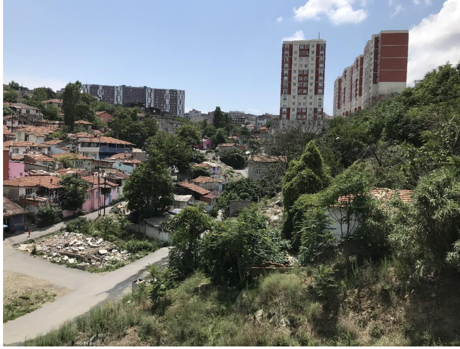
Foto 18: Sarıgl Mahallesinde yeni yapılan ve yıkılmayı bekleyen konutlar bir arada bulunmaktadır.
