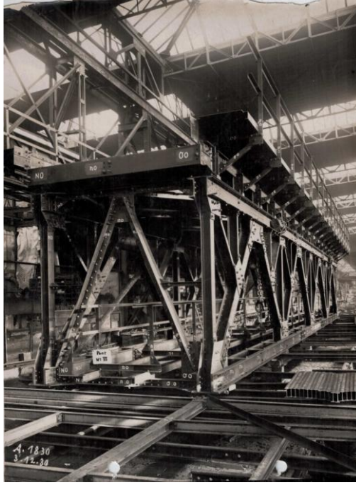
Resim IV: Fabrika da yapımı sırasında Bekdemir Köprü Parçası.
