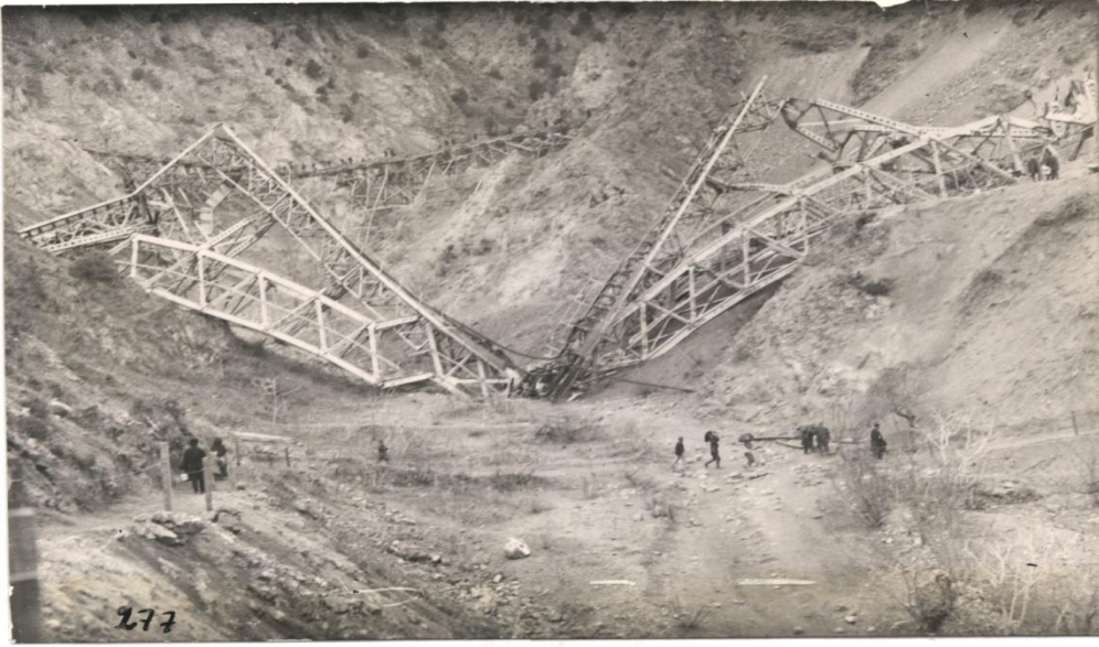
Resim VI: Patlatılan Başköy Köprüsü.
