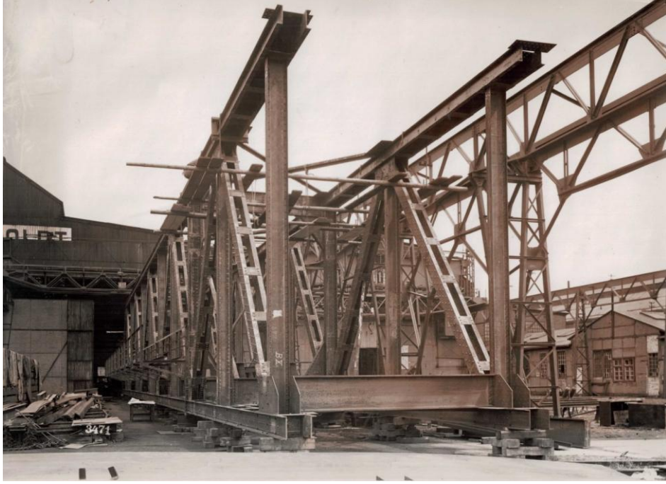
Resim I: Fabrikada yapımı sırasında Cambazkaya Köprüsü.
