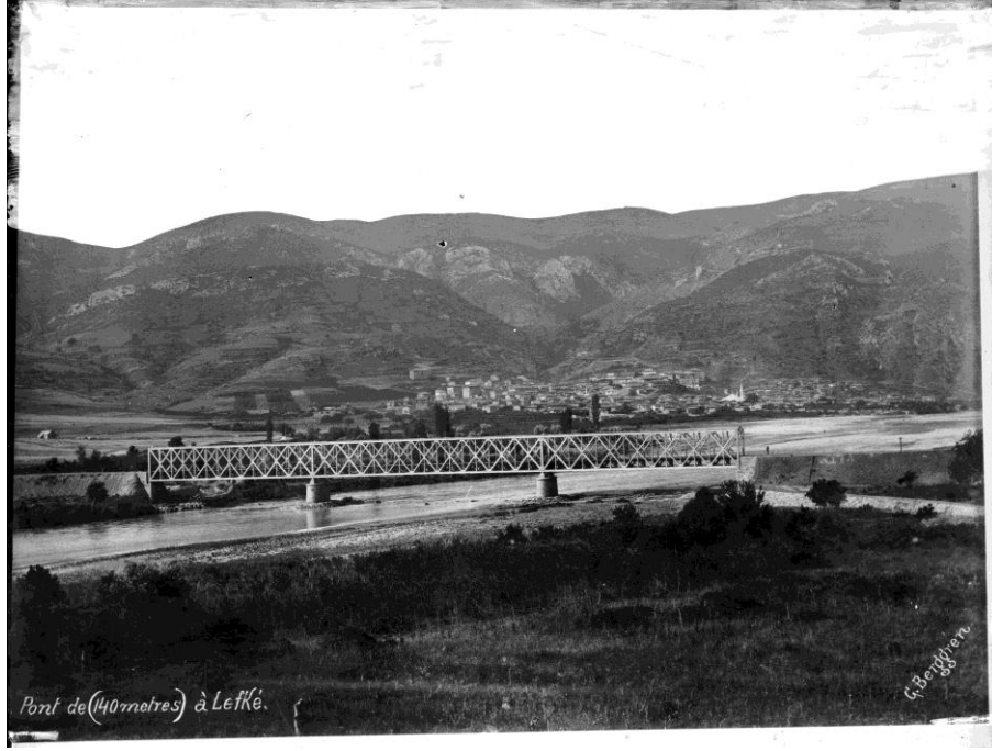
Resim II: Bilecik-Lefke Demiryolu Köprüsü.
