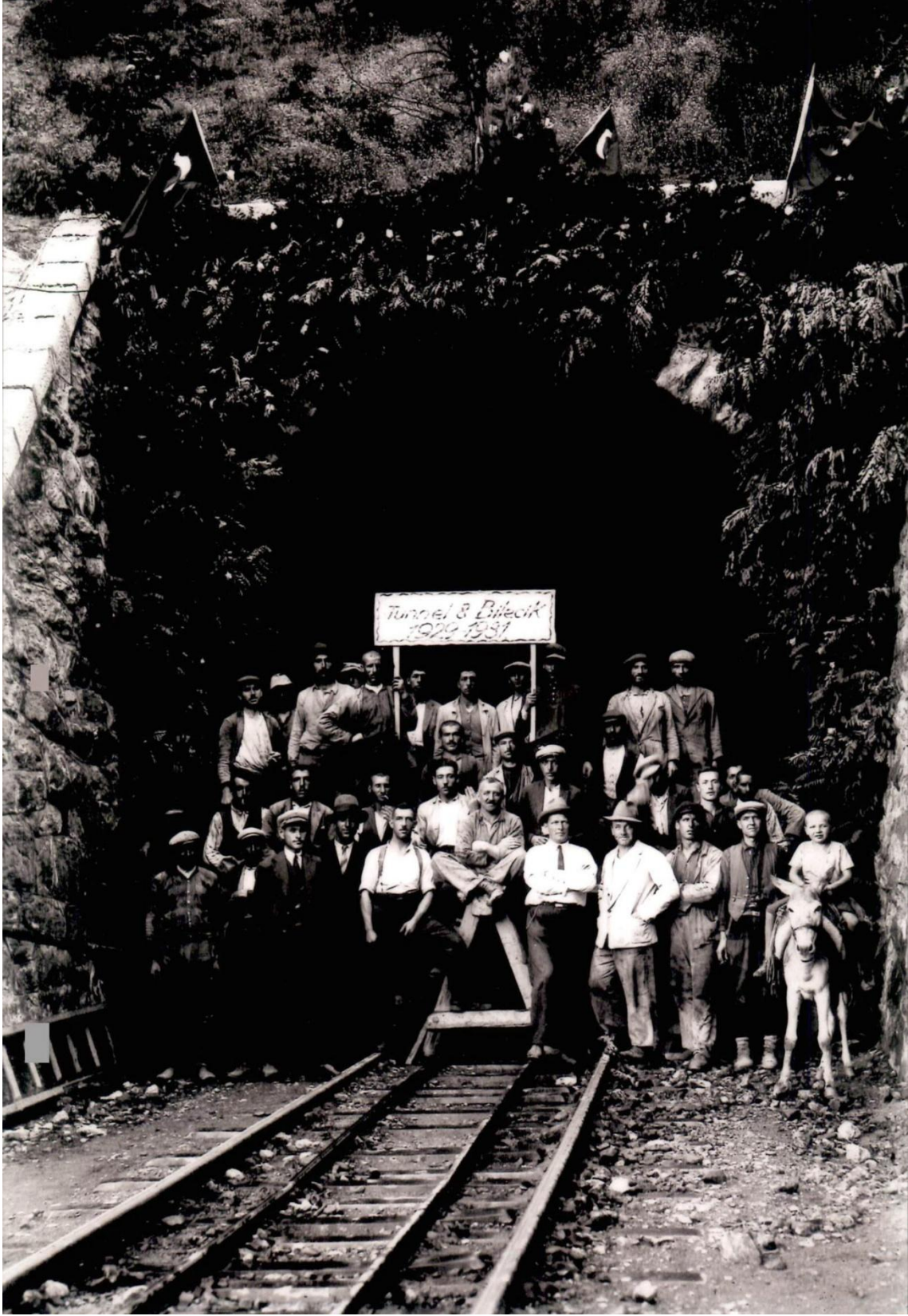
EK XVIII- Resim XXXIII: Yayla 8. Tünel Onarım Çalışmaları.
