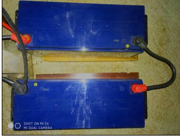
Şekil 4.7. Seri bağlı 12V 150Ah jel batarya grubu
