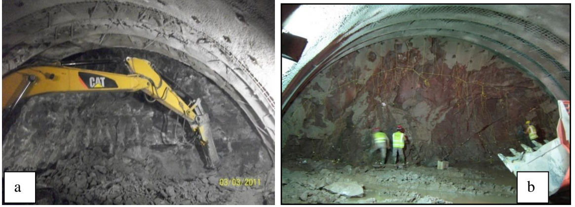
Şekil 2.4. Klasik kazı yöntemleri (a-hidrolik kırıcı, b-delme-patlatma) (Poşluk, 2012).
