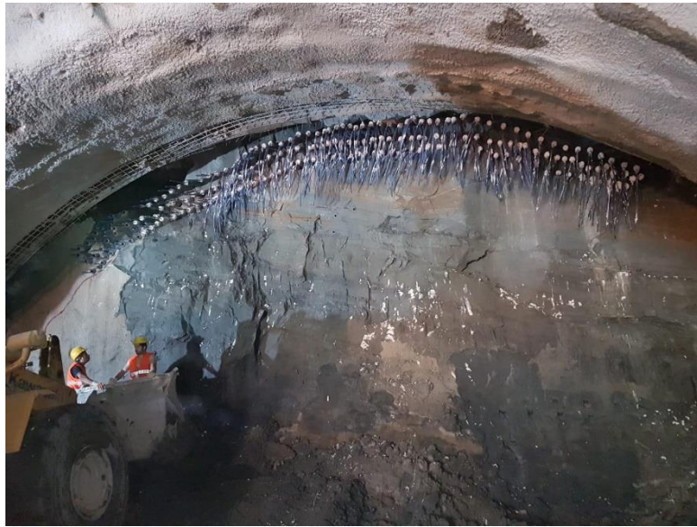
Şekil 2.12. Süren uygulaması (Ankara-İstanbul Yüksek Hızlı Tren Projesi 2 numaralı tünel, Adapazarı)
