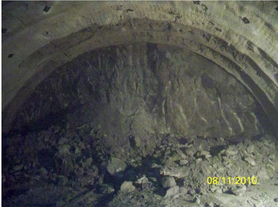
Şekil 7.3. 35 nolu tünelde geçilen Bozüyük Granatoidi.
