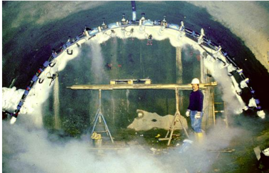
Şekil 2.13. Tünelde zemin dondurma yönteminin uygulanması (Arioğlu, 2018).
