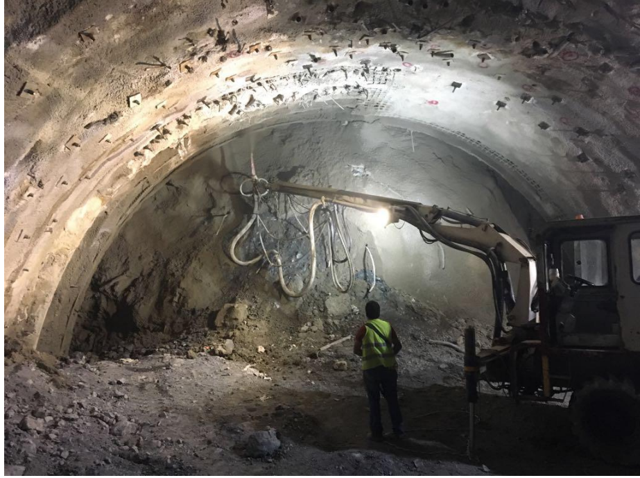
řekil 2.9. Tnel iinde pskrtme beton uygulaması (Ankara-İstanbul Yksek Hızlı Tren Projesi 19 numaralı tnel, Bilecik).
