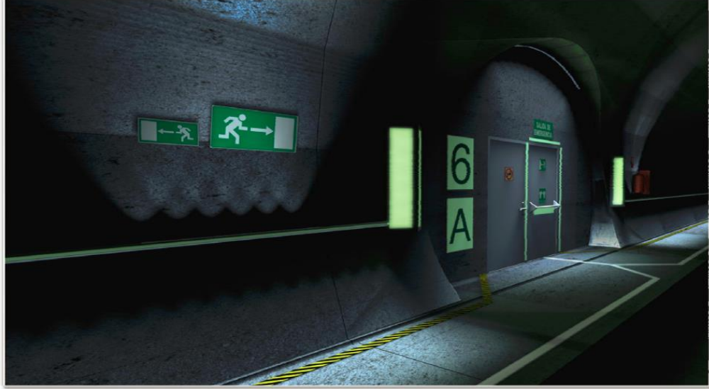
řekil 4.7. Acil durum ıřıklandırması ve acil durum ıkıřı (Pořluk vd., 2012).
