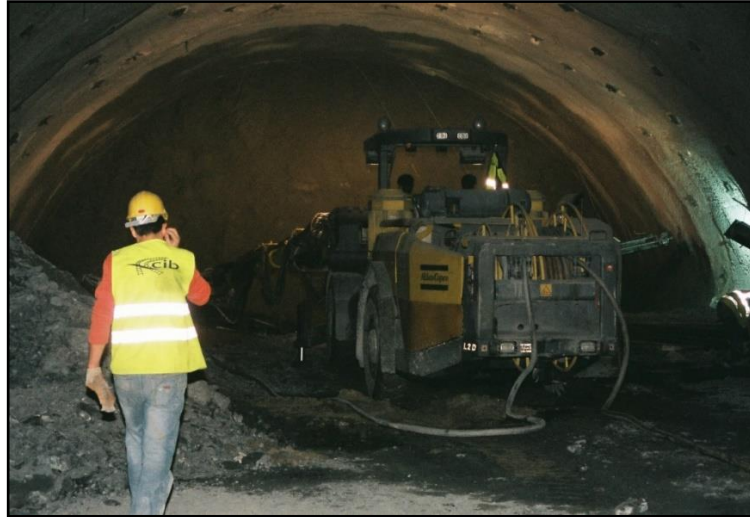
Şekil 2.10. Kaya bulonu uygulaması (Ankara-İstanbul Yüksek Hızlı Tren Projesi 8 numaralı tünel, Adapazarı).
