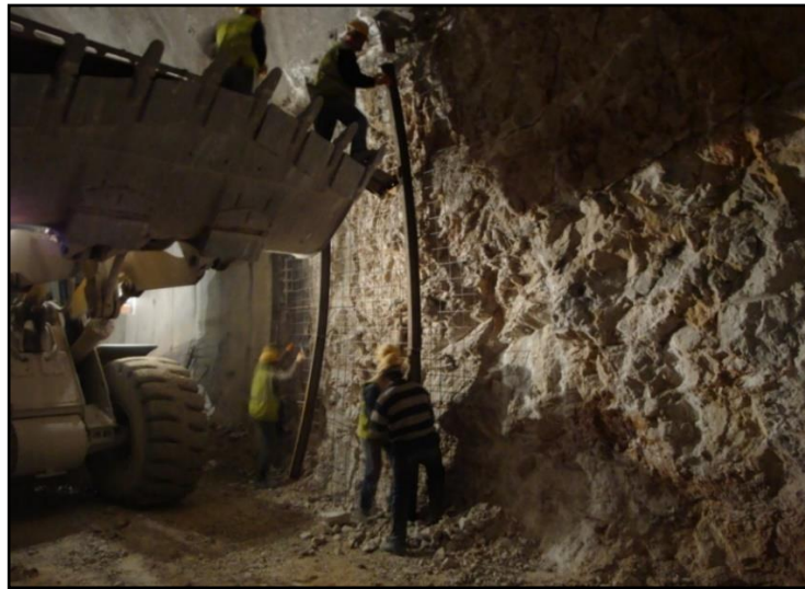
Şekil 2.11. NATM destekleme elemanlarından hasır çelik ve çelik iksa uygulaması (Ankara-İstanbul Yüksek Hızlı Tren Projesi, Bilecik).
