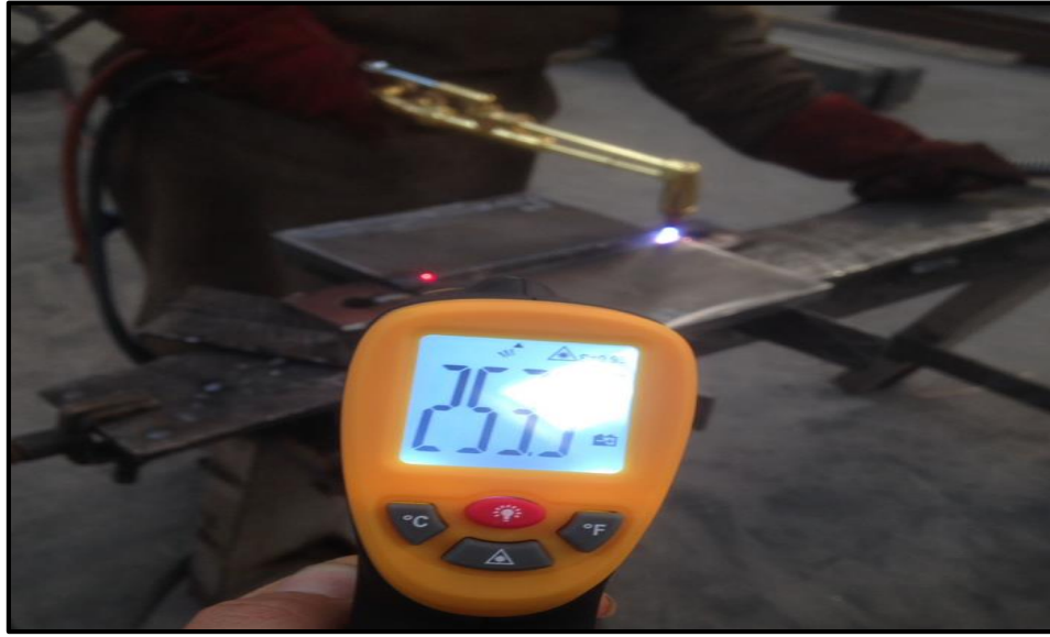
Şekil 4.15. Pasolar arası geçiş sıcaklığı uygulaması ve kontrolü.
