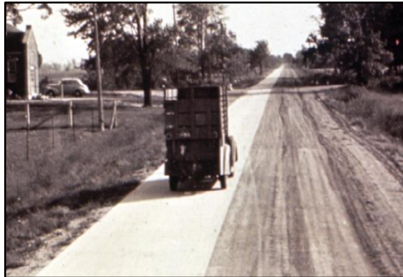
Şekil 2.2. ABD’de 1910 yılında inşa edilen beton yol (Snyder, 2008).
