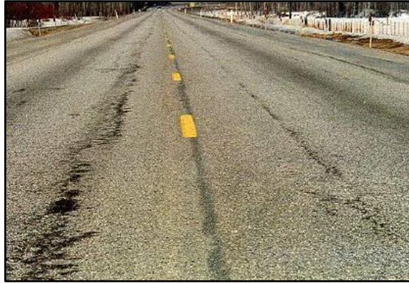
Şekil 2.10. Sökülme ve soyulmaların genel görünümü (Karaşahin, 2014)
