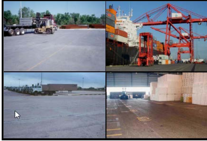
Şekil 2.5. İskele, liman, nakliye alanlarında, fabrika içi yollarda, depo ve park alanlarında SSB uygulaması (Aghabaglou, 2011).
