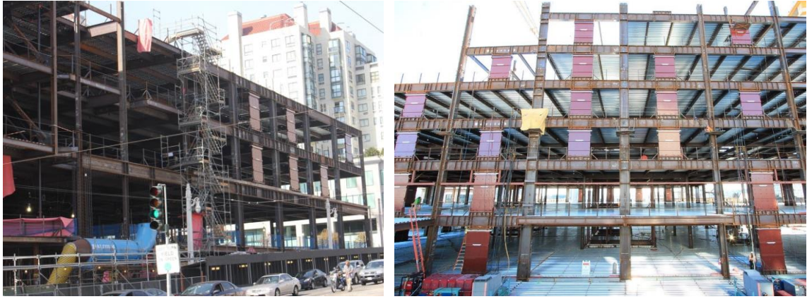
Şekil 1.15. Bir hastane yapısında viskoz sönümleyici duvar uygulaması (Dilsiz vd., 2018; Dynamic Isolation Systems, 2019).
