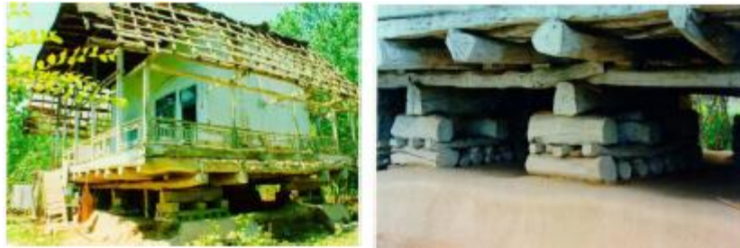
Şekil 1.5. Yuvarlak kütüklerle deprem izolasyonu (Naderzadeh, 2009).
