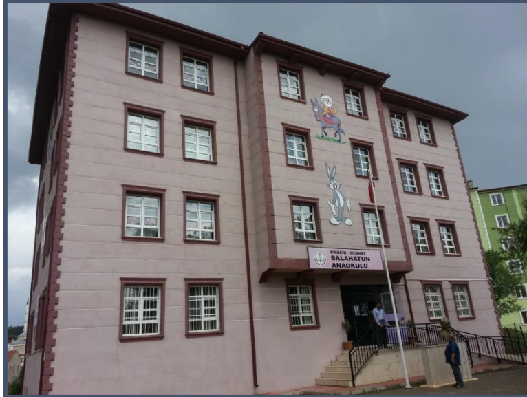
Şekil 4.1. Okul Binası Ön Cephe Görünümü
