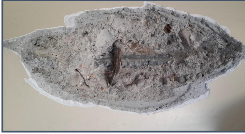
Şekil 4.5. Paspayının Kırılması İle Donatı Tespiti Yapılması (Örseleme)
