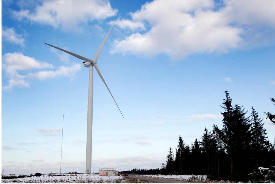
řekil 2.6. Vestas retici firmasının V164 model 8 MW (daha sonrasında 10 MW olarak geliřtirilmiř) gce sahip ilk prototipi (Wikipedia, 2020a).
