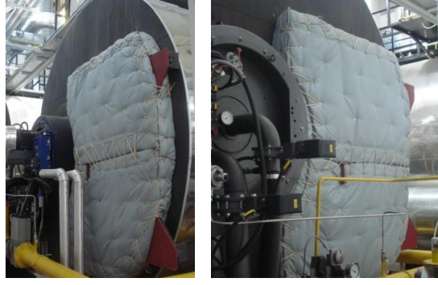
Şekil 5.24. Ön kapak için önerilen yalıtım ceketi
