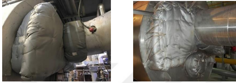
Şekil 5.29. Duman borusu için önerilen yalıtım ceketleri ve yastığı
