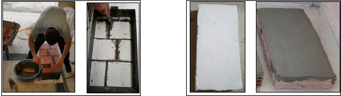
Tuğla, gazbeton duvar örümü
