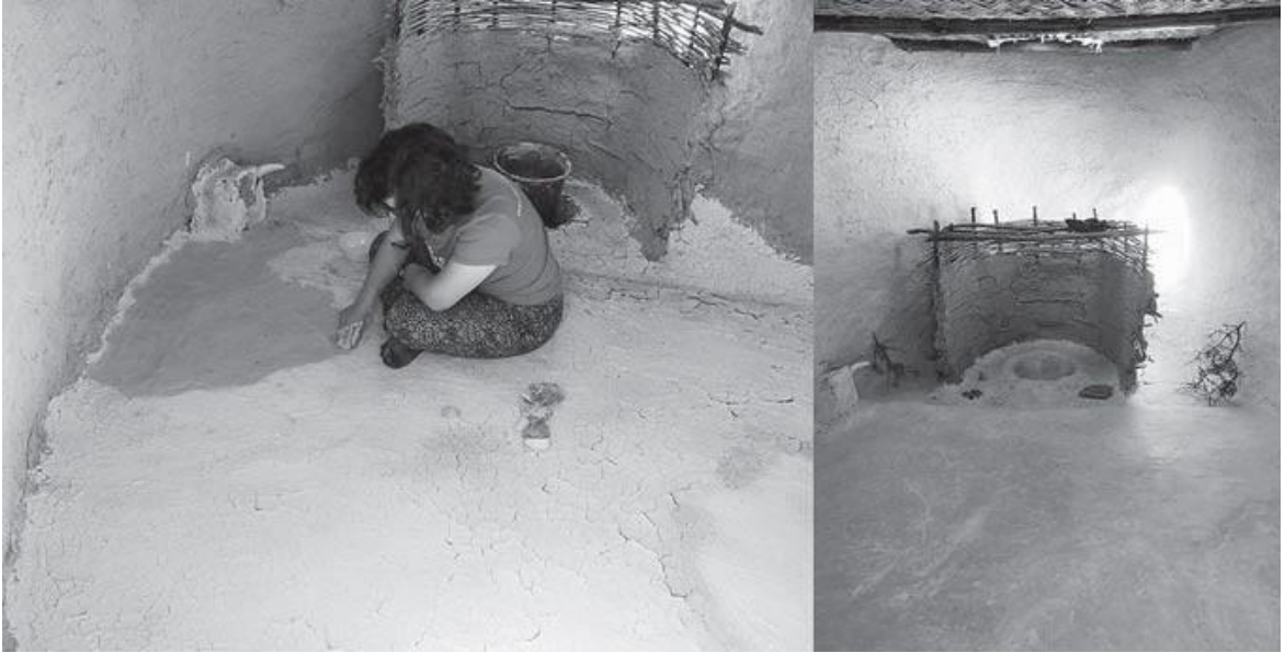
Resim 2.8. Taban Sıvası Üzerinde Perdahlama Tekniğinin Kullanımı.
