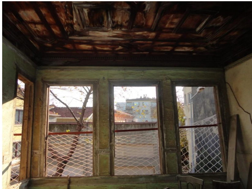
Şekil 5.3. Dikmeler ve çatı taşıyıcıları.
