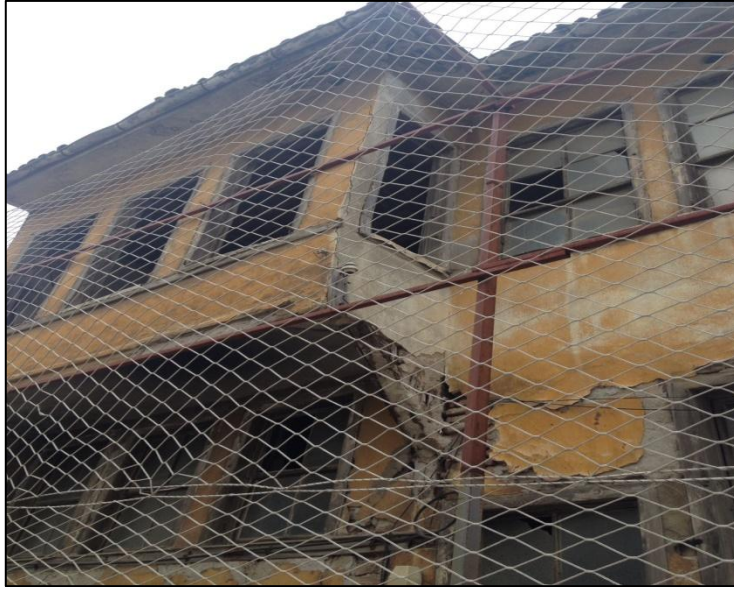
Şekil 5.1. Yapının önden görünüşü.
