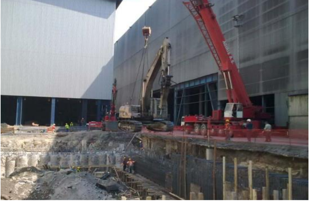
Şekil 3.5. İksa sistemi arkasında sürşarj yükü oluşturan ekipmanlar (Dayıoğlu 2010).
