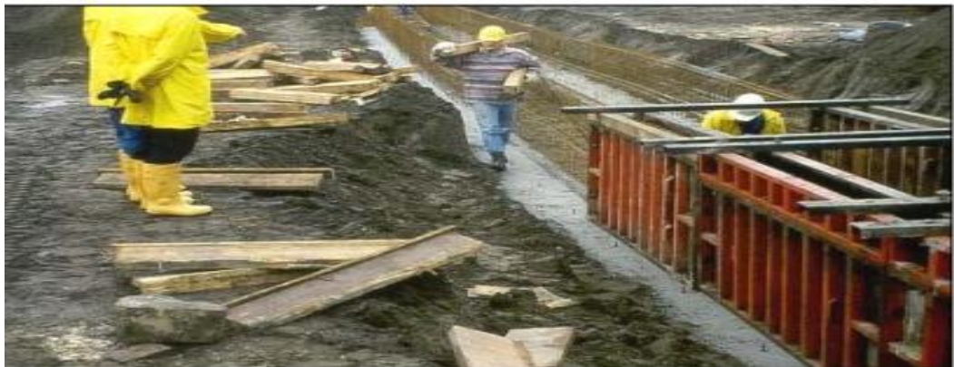
Şekil 4.2. Kılavuz Duvar (Natural Zemin 2016).
