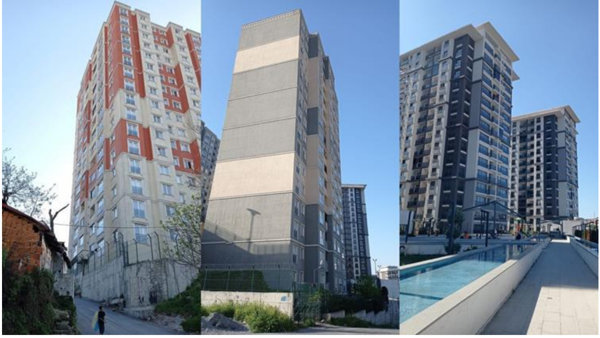
Şekil 4. 13. Sarıgöl Mahallesiinde kentsel dönüşümle sırasıyla yapılan konutlar
