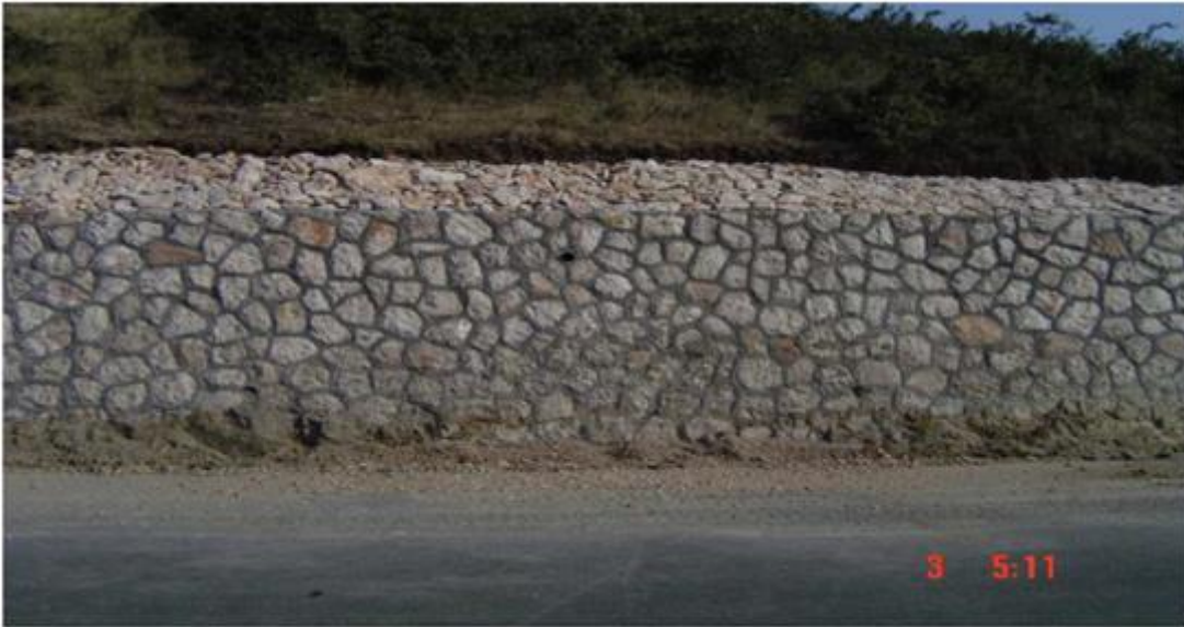
Şekil 3. 5. Tamamlanmış harçlı taş istinat duvar fotoğrafı
