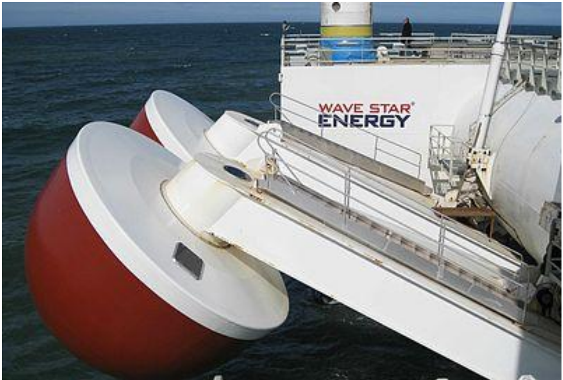
Şekil 4.31. Fırtınalı havalarda dubaların sabitlenmesi.
