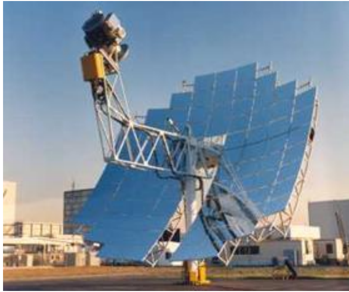
Şekil 3.16. Merkezi alıcılı çanak kolektörlerin yapısı.
