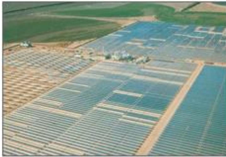
Şekil 4.5. SEGS I güç santrali (NREL, 2017).
