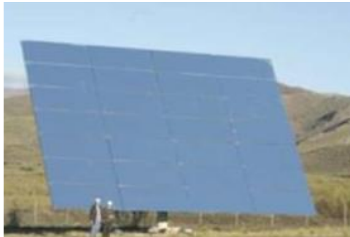
Şekil 5.5. Sabit kesimli aynadan yapılmış 120 m 2 lik heliostat yapısı.
