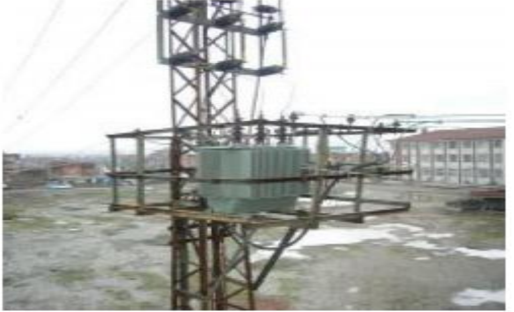
Şekil 2.3. Gerilimin düşürülmesi işlemi (Özkan, 2014).
