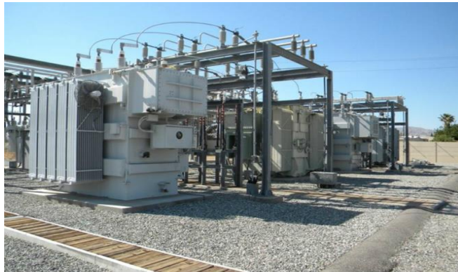
Şekil 4.1.Paralel bağlı transformatörler(Elektrikport, 2018).
