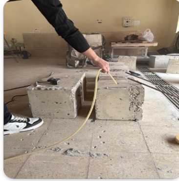
Şekil 4.8. Açılan Deliklerin Hava Basıncı İle Temizlenmesi
