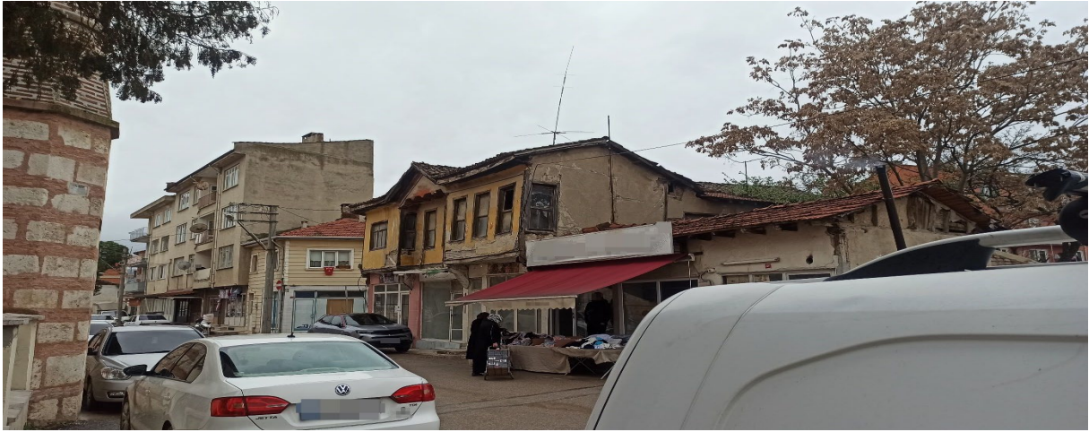
Fotoğraf 1.1 İlçe Merkezine Ait Simetriği Bozulmuş Eski Yapı
