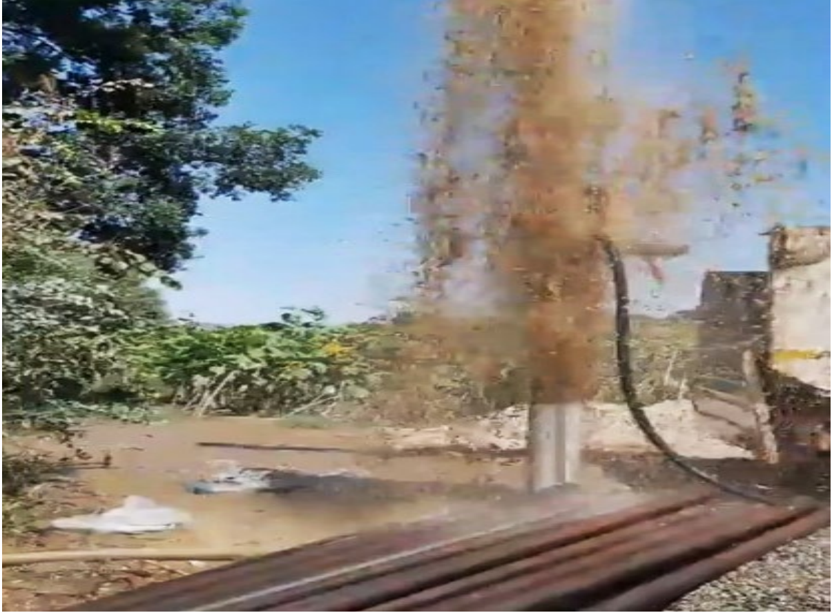
Fotoğraf 3.1 Bölgede Yapılan Sondaj Çalışmaları
