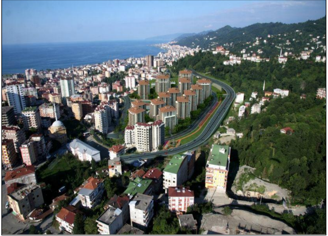
Foto 7: Timya Vadisi Kentsel Dönüşüm Projesi Sonrasından Bir Görünüm
