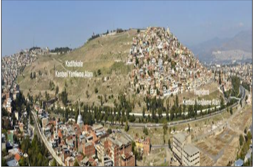
Foto 5: Kadifekale Kentsel Dönüşüm Projesi Sonrası Yıkılan Alan
