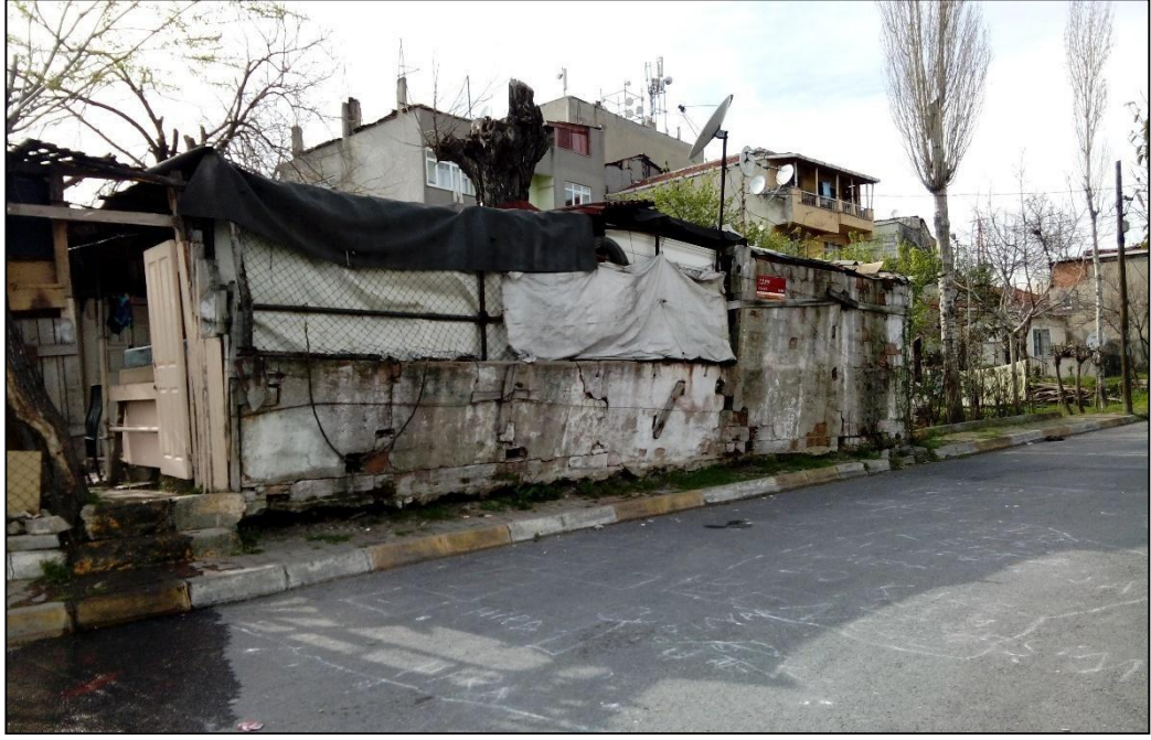
Foto 16: Çifte Havuzlar Mahallesi'nde Bulunan Kaçak Yapılardan Bir Görünüm, 2015
