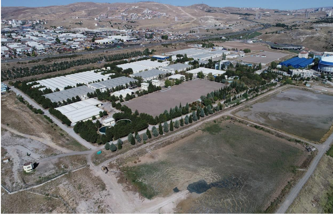
Şekil 3.1. İvedik Su Arıtma Tesisi
