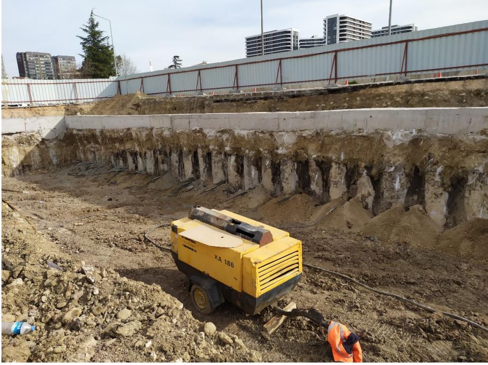
Şekil 2.15 Sahada Ankraj Uygulaması
