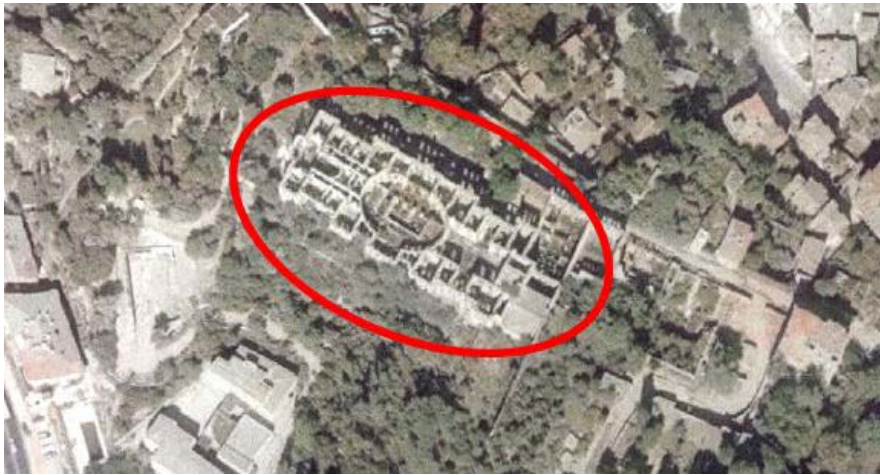
Şekil 1.8. 1986 yılında çıkan yangından sonra Adile Sultan Sarayı'nın 1987 Ortofotoya göre havadan çekilen görüntüsü, CBS.
