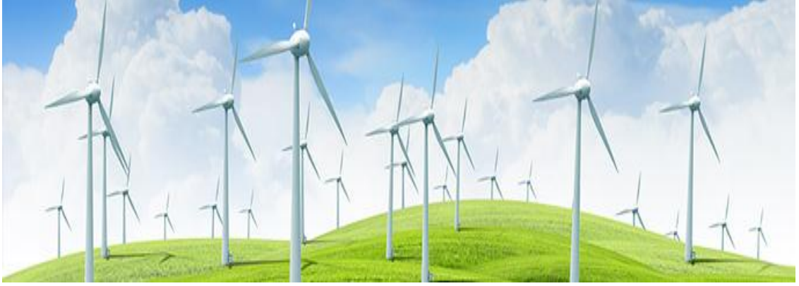
Şekil 2.5. Rüzgâr enerji santrali (ETKB, 2016).
