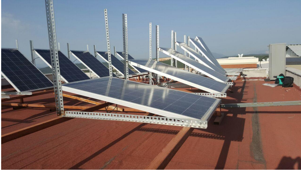
Şekil 4.21. Farklı eğim açılarındaki panellerin kurulum düzeneği.
