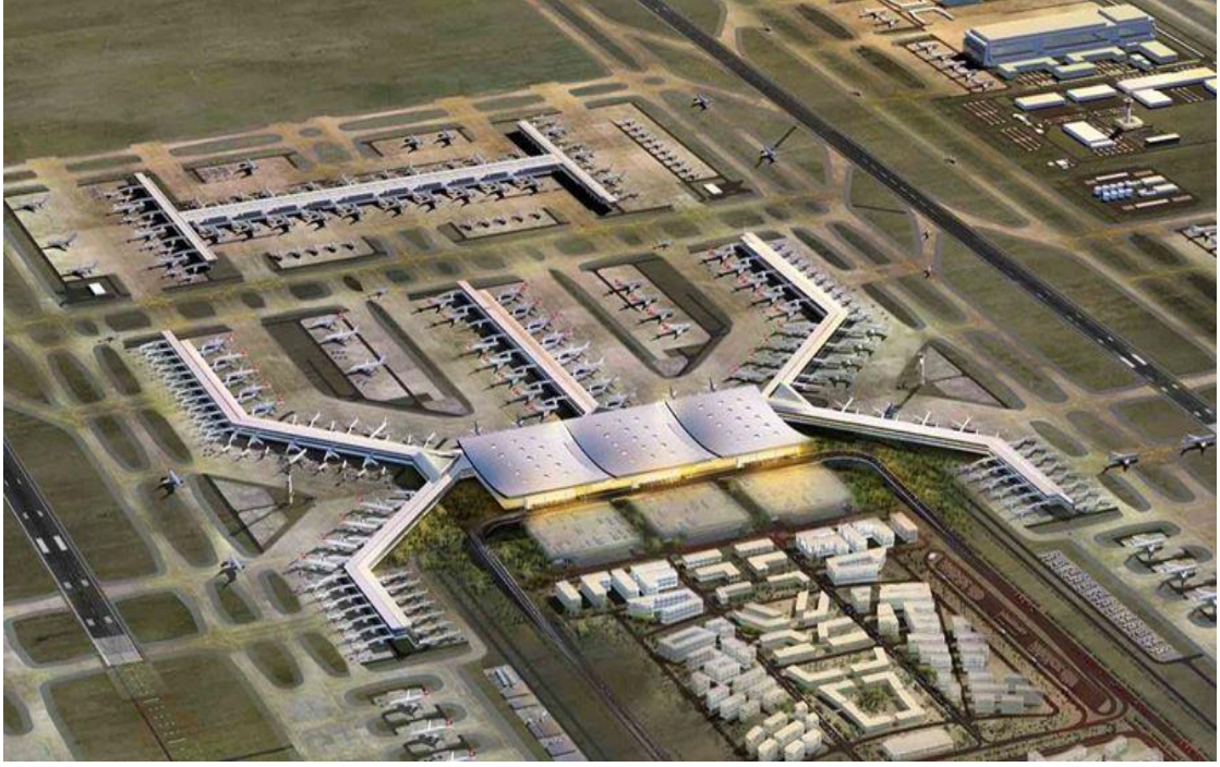
Şekil 2.30. İstanbul Havalimanı (www.architectmagazine.com)
