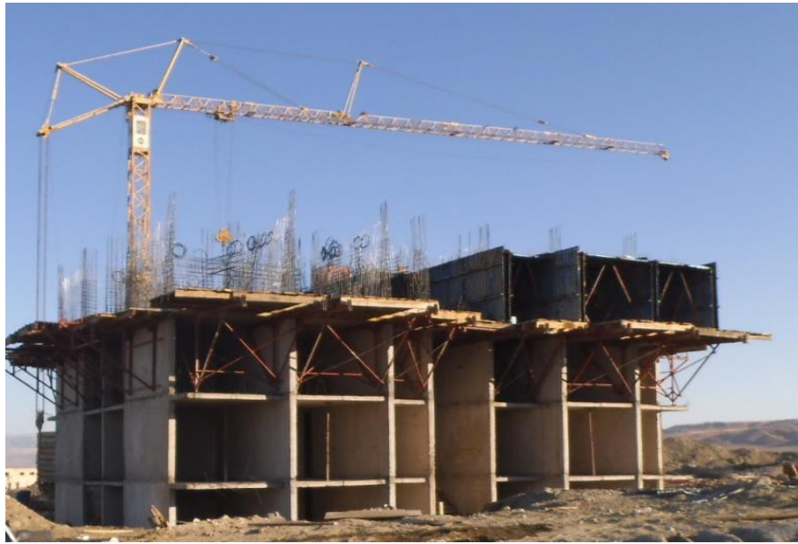
Şekil 3.4. Toplu konut tünel kalıp uygulaması.
