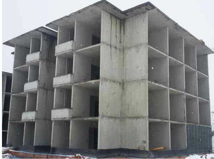
Şekil 4.30. Tünel kalıp sistem imalat görünümü (TOKİ)
