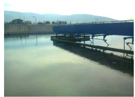
Şekil 3.41 Son çöktürme ve deşarj havuzları.
