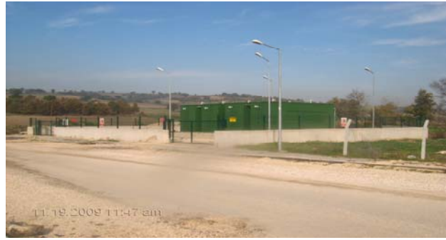
Şekil 3.51 Kayapa atıksu arıtma tesisi.
