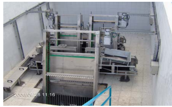
Şekil 3.49 Mudanya atık su ön arıtma tesisi.
