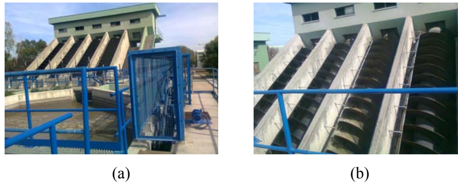
Şekil 3.37 (a) birinci kademe arıtma pompası, (b) ikinci kademe arıtma pompaları.
