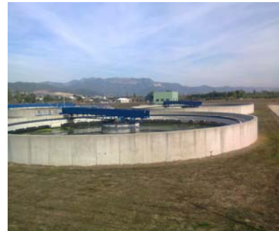
Şekil 3.41 Son çöktürme ve deşarj havuzları.
