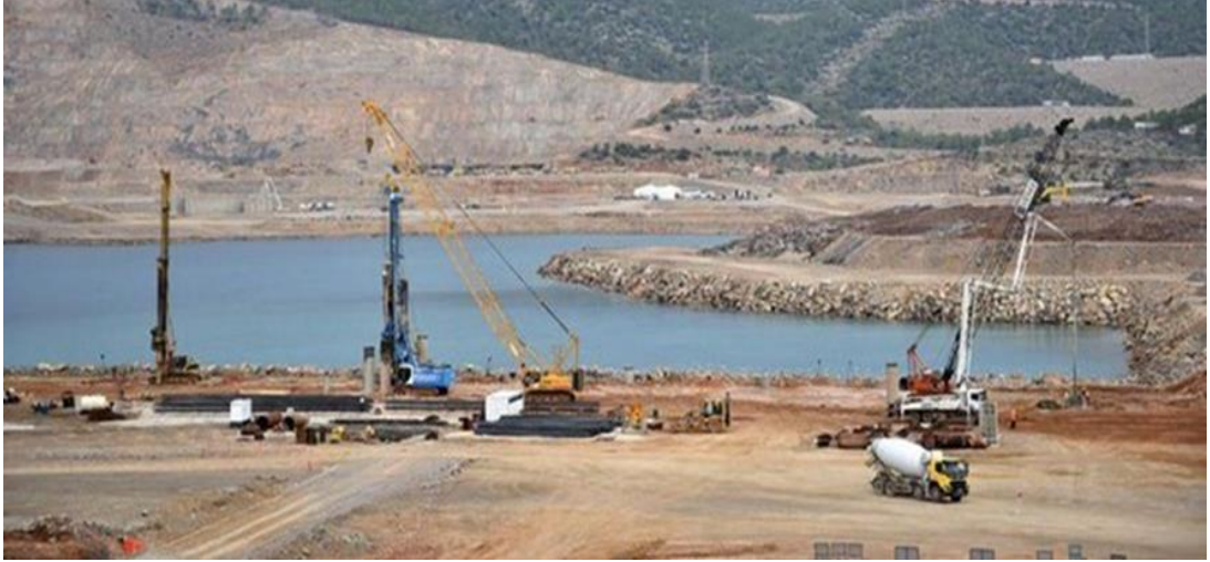
Şekil 2.15 NGS yapılacak olan Akkuyu Çalışma Sahası
