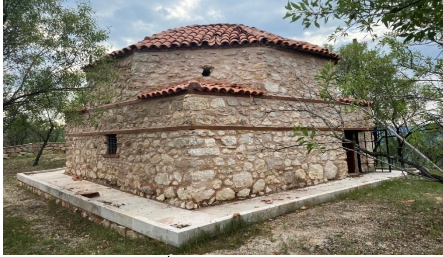
Resim 17: İsa Sofi Türbesi Dıştan Görünüş Kaynak: Kişisel arşiv.
