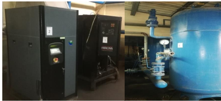
Şekil.4.3. Hava kurutucuları ve hava tankları.
