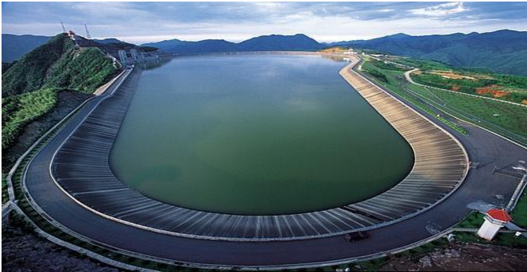
Şekil 5.2. Guangdong Pompaj Depolama Tesisi
