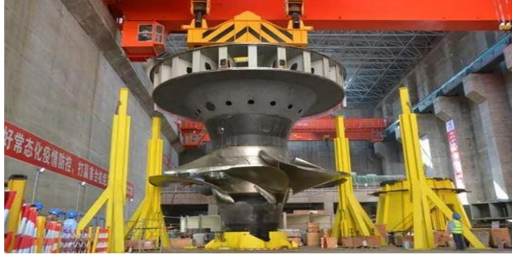
Şekil 3.3. Kaplan Türbin
