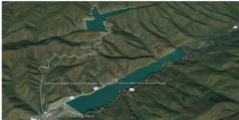
Şekil 5.4. Bath County Pompaj Depolama İstasyonu
