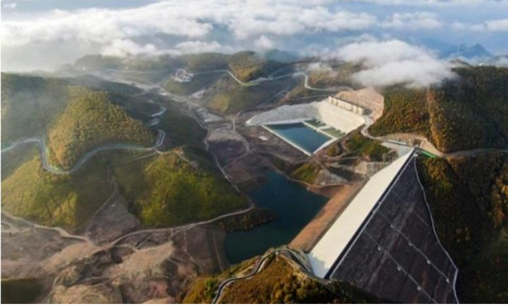
Şekil 5.3. Fengning Pompaj Depolama Santrali
