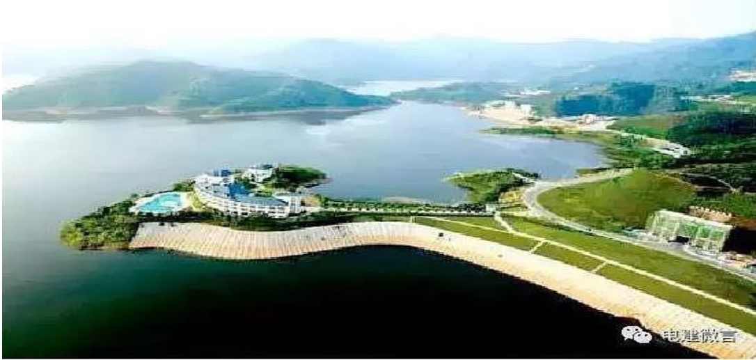
Şekil 5.1. Huizhou Pompaj Depolama Santrali
