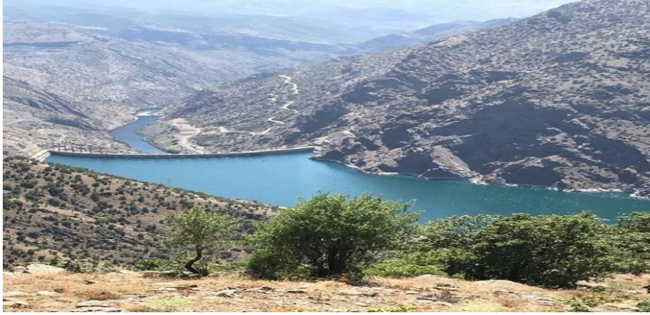
Şekil 3.9. Karakaya Barajı ve HES
