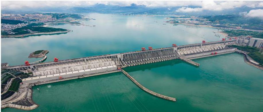
Şekil 3.7. Üç Boğaz Barajı
