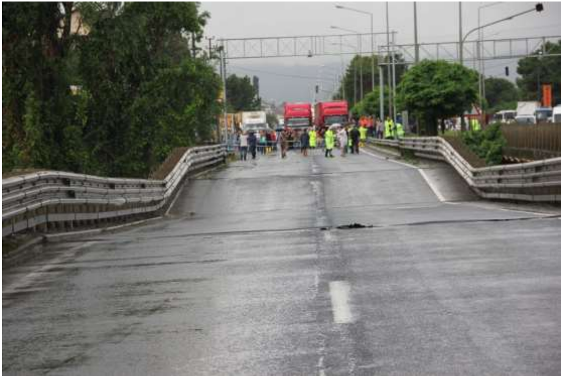
Şekil 4.5. Ordu, Ünye sahil yolu köprüsü, sel afeti, (URL 5, 2019).
