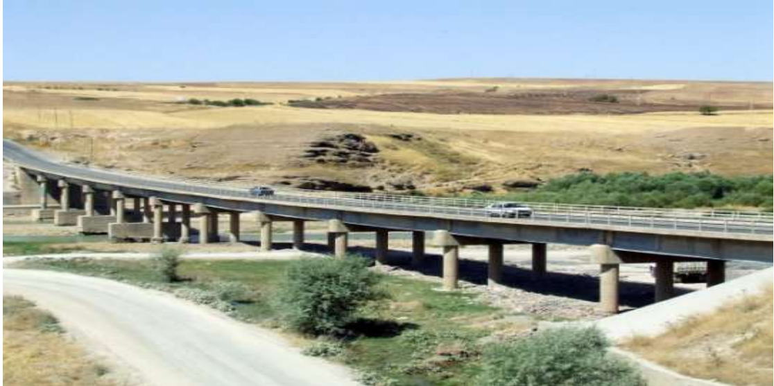
Şekil 4.3. Adıyaman Göksu köprüsü, (URL 7, 2020).
