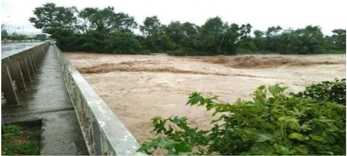
Şekil 4.6. Ordu, Ünye sahil yolu köprüsü, sel afeti, (URL 5, 2019).
