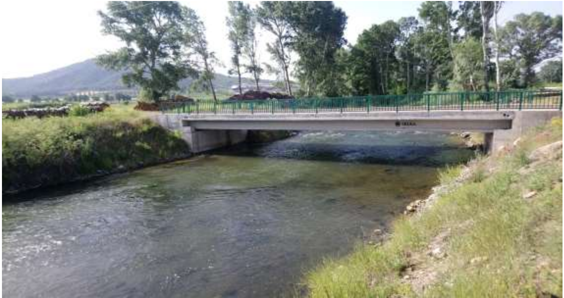
Şekil 6.22. Fidanlık Köprüsü tamamlanmış hali
