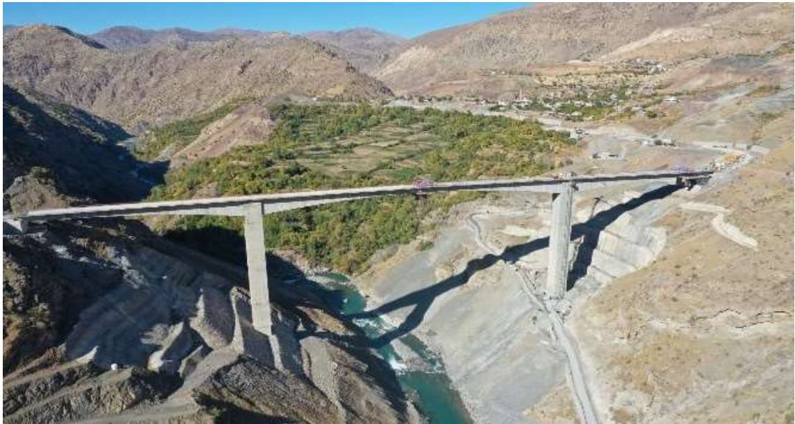
Şekil 4.11. Botan köprüsü, (URL 8, 2020)
