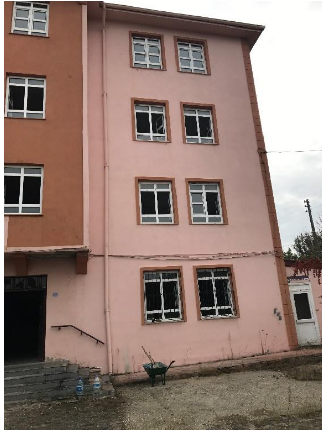
Şekil 4.2. Betonarme yapının görüntüsü
