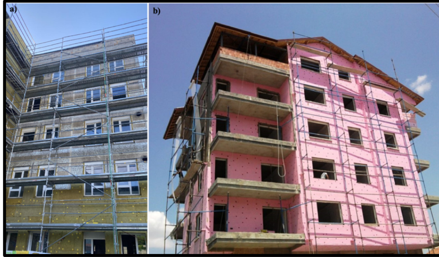
Şekil 2.18. Farklı yalıtım malzemeleri kullanılarak gerçekleştirilen mantolama uygulamaları (Hepsiemlak, 2026 ve Mecidoğluyapı, 2026).
