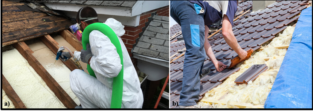
Şekil 2.19. Farklı yalıtım malzemeleri kullanılarak gerçekleştirilen çatı yalıtımı (Gunogluizolasyon, 2026 ve Elveren, 2026).
