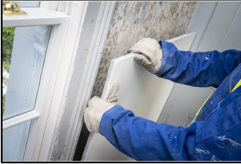
Şekil 2.50. Levha formundaki arojeller ve uygulaması (Tapecompanies, 2026).
