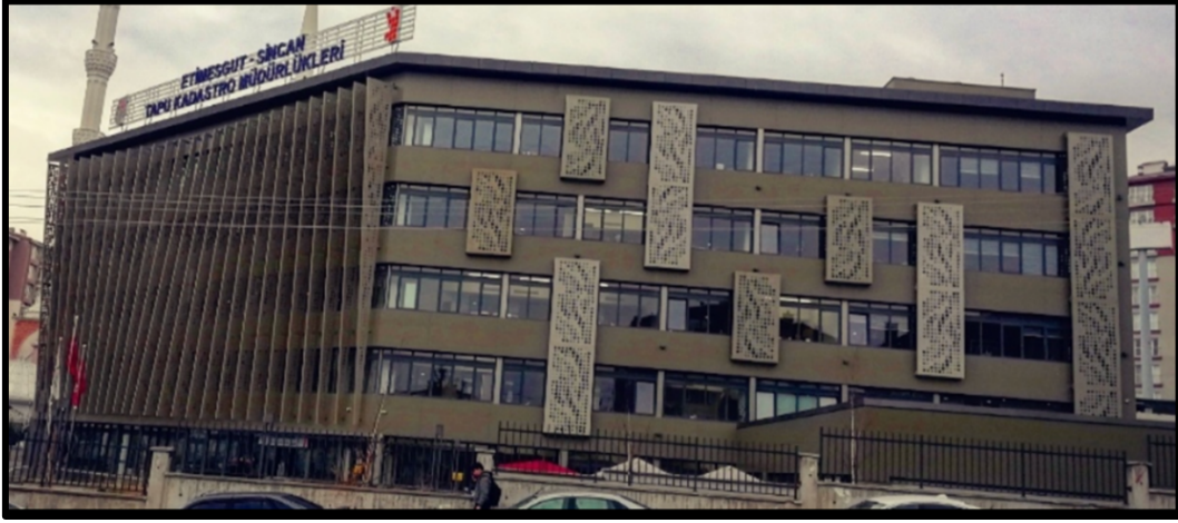
Şekil 2.2. Türkiye’de EEBT yaklaşımıyla inşa edilen ilk pilot uygulama.
