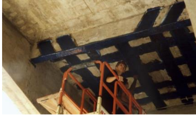
Şekil 4. CFRP Kumaşın betonarme kiriş ve döşemeye uygulanması [19]
