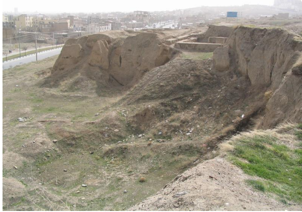
Resim 4.8. Hemedân'da Med Döneminden Kalan Teras Duvarı
