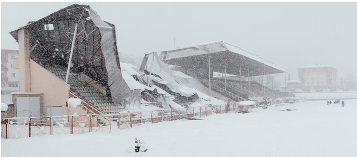
Şekil 1.1. Bilecik Edebalı Stadı çatısının çökmesi(URL-1).
