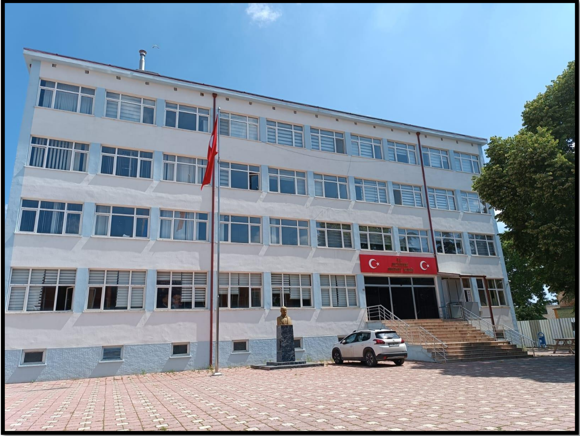
Fotoğraf 3.23. Pazaryeri Hükümet Konağı Binasından Görünüm.
