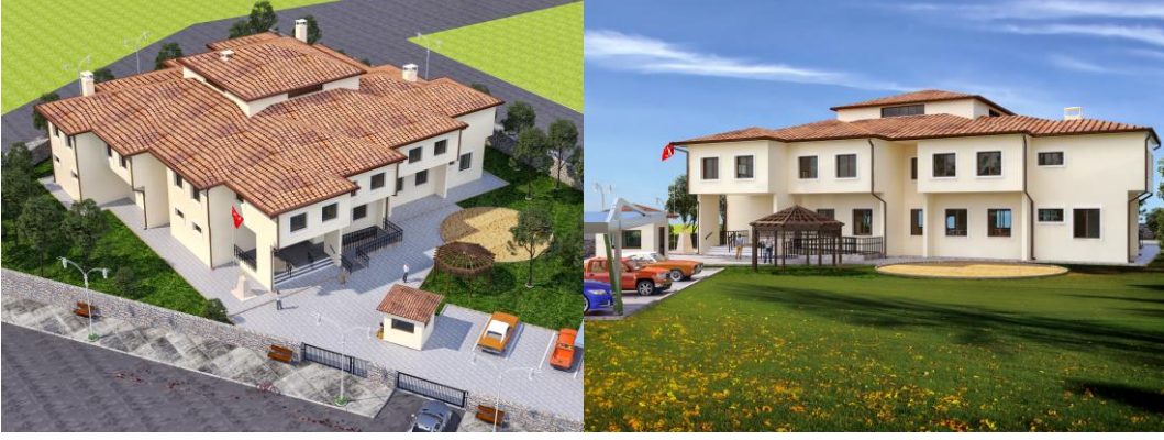
Şekil 4. 2. KB-2 kodlu Kamu binasının dış cephe görünümü (2024).
