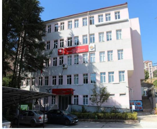
Şekil 4. 4. KB-4 kodlu Kamu binasının dış cephe görünümü (2024).
