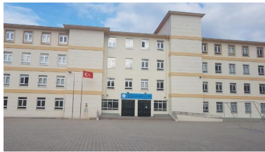
Şekil 4. 5. KB-5 kodlu Kamu binasının dış cephe görünümü (2024).
