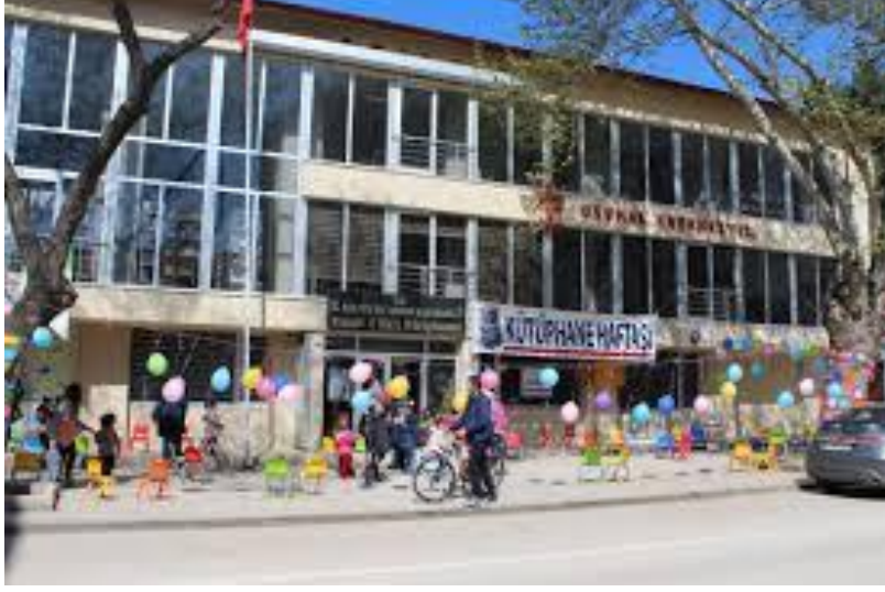
Şekil 4. 1. KB-1 kodlu Kamu binasının dış cephe görünümü (2024).
