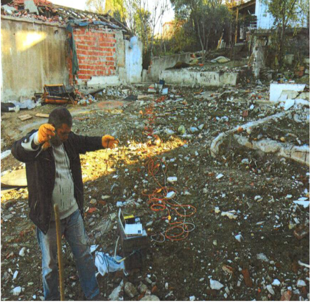
Şekil 6.1. Arazide yapılan sismik kırılma çalışması.
