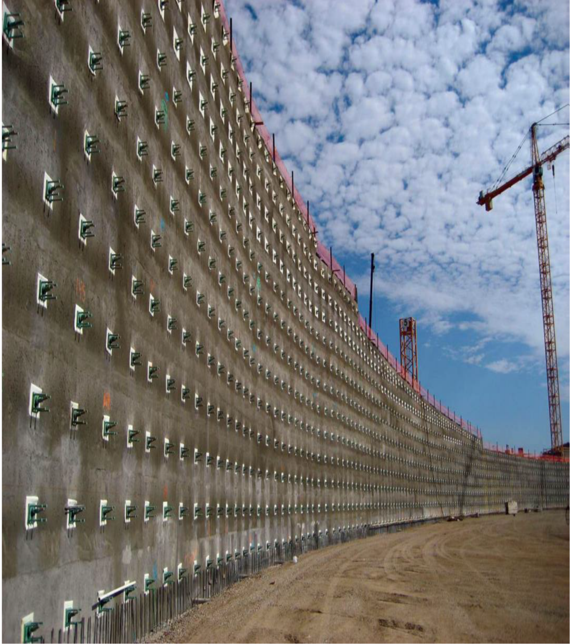
Şekil 4.16. Zemin çivili iksa inşaatı - Dallas Stadyumu, Texas, USA.(Haywardbaker Company).
