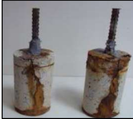
Şekil 3.4. Betondaki paslanma etkisi (Boğa, 2010)
