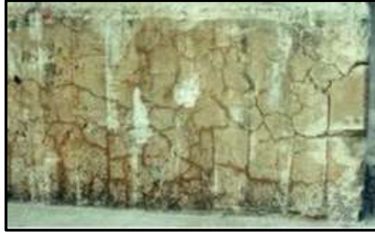
Şekil 3.5. Asit saldırısına uğramış beton (Yazıcı, 2014).
