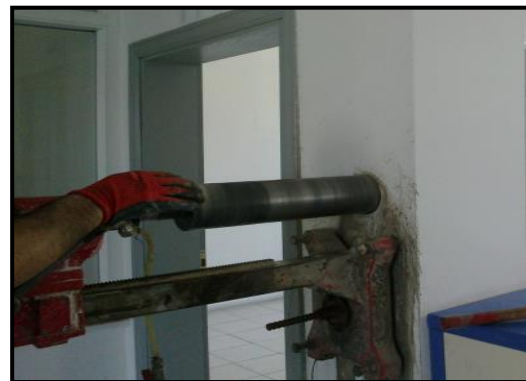
Şekil.1.Yapıdan Karot Numune Alımı (Concrete Core Sampling Of Construction)
