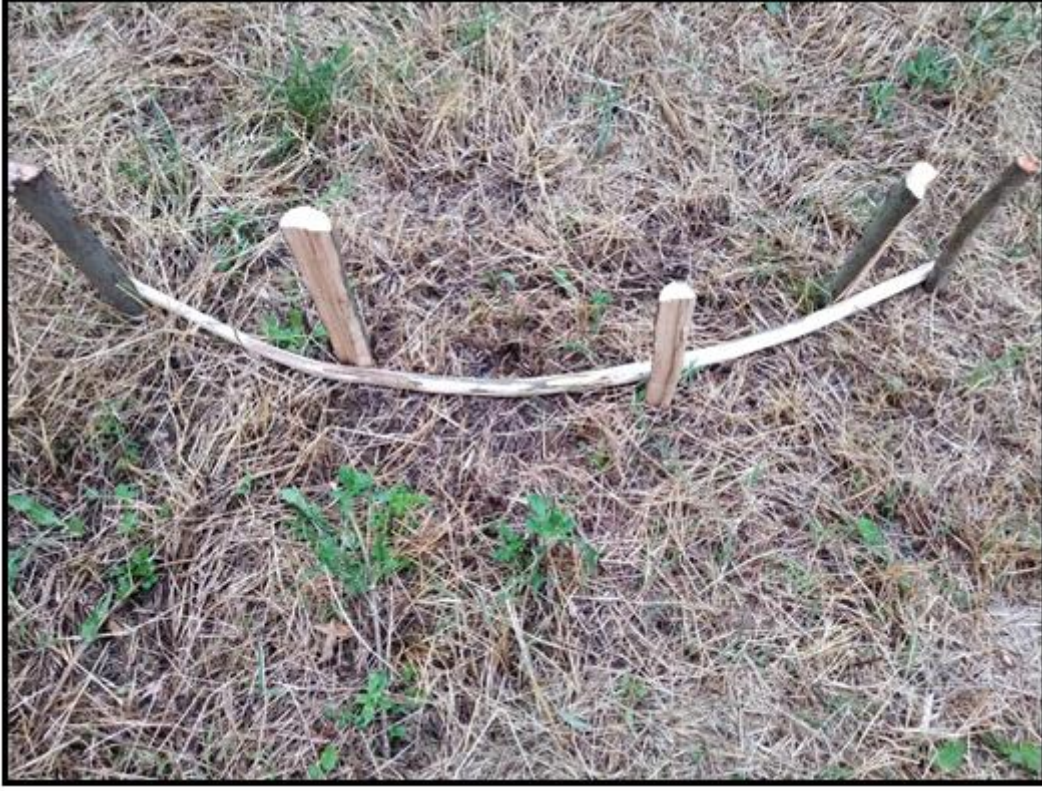
Resim 14: Yay kavsının verilmesi
