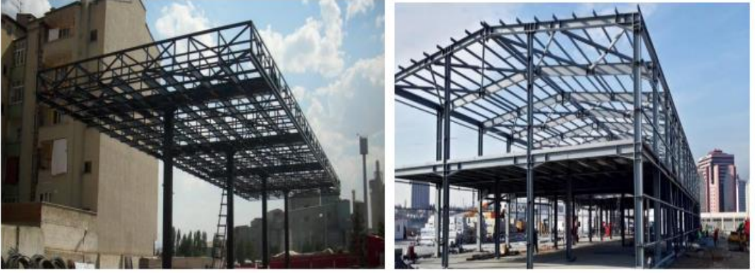
Şekil 1.1. İnce cidarlı taşıyıcı elemanların kullanımı (Eroğlu, 2019)
