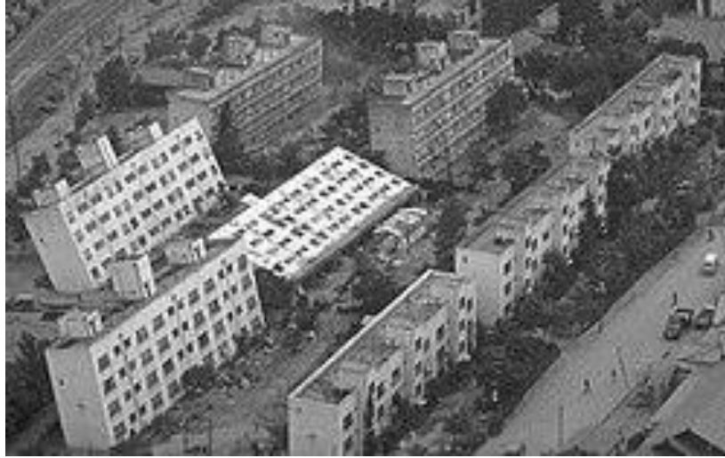
Şekil 3.24.: 1964 Niigata derpremi, sıvılaşma problemi (Ishihara ve Koga, 1981)
