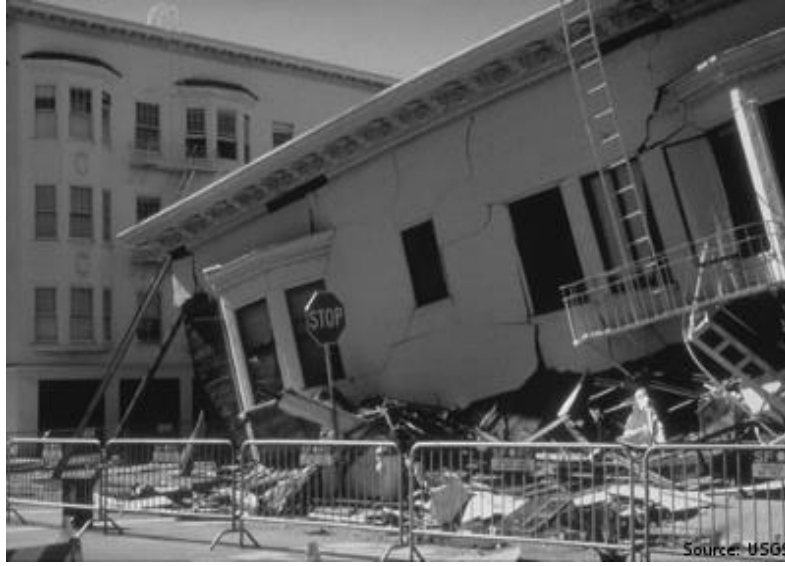
Şekil 3.26.: 1989 Loma Prieta depremi, CI zeminde oturmalar (USGS, 2018)
