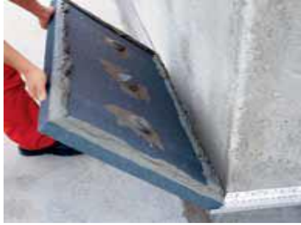
Şekil 7.4. Yalıtım levhasının yapıştırma uygulaması (Vitra, 2013).
