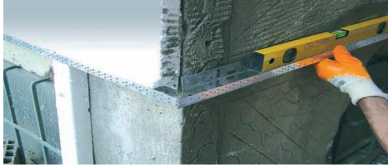
Şekil 7.10. Su basman profili uygulaması (EPS Sanayi Derneği, 2017).
