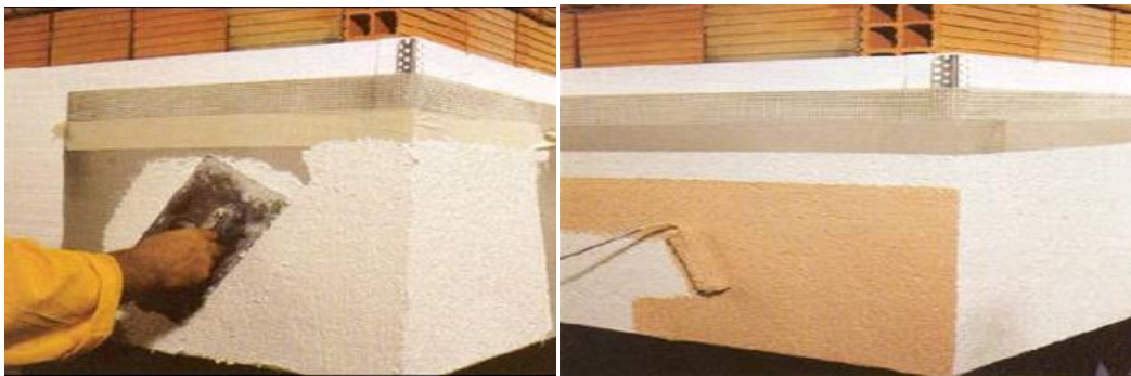
Şekil 7.11. Son kat dekoratif kaplama uygulaması (İzoder, 2013).
