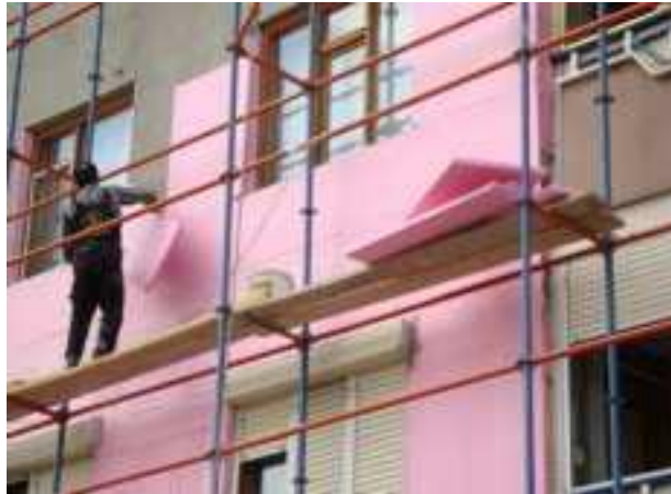
Şekil 7.1. Dıştan yalıtım uygulaması (Koçu ve Dereli, 2010).
